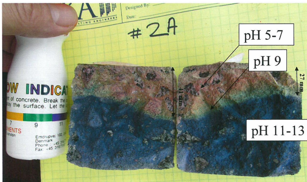
Preparat „Rainbow - Test” – pomiar stopnia karbonatyzacji (pH) betonu na przełomie odwiertu – zbrojenie zagrożone korozją do głębokości około 27 – 41 mm (powyżej koloru niebieskiego)
